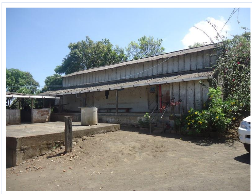
Figura 3: Instalaciones de El Castillo
