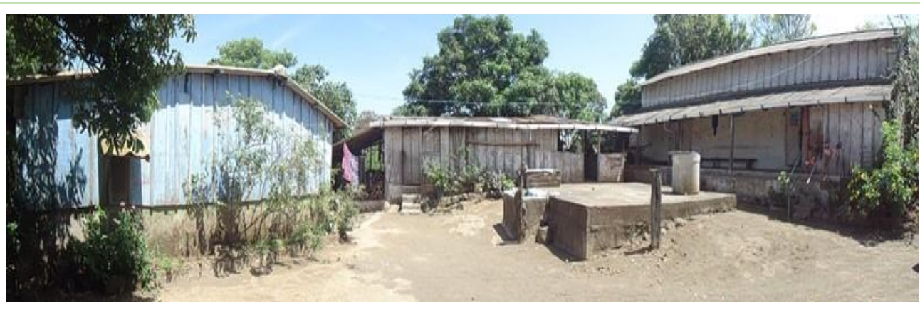
Figura 16: Principales instalaciones de la finca
