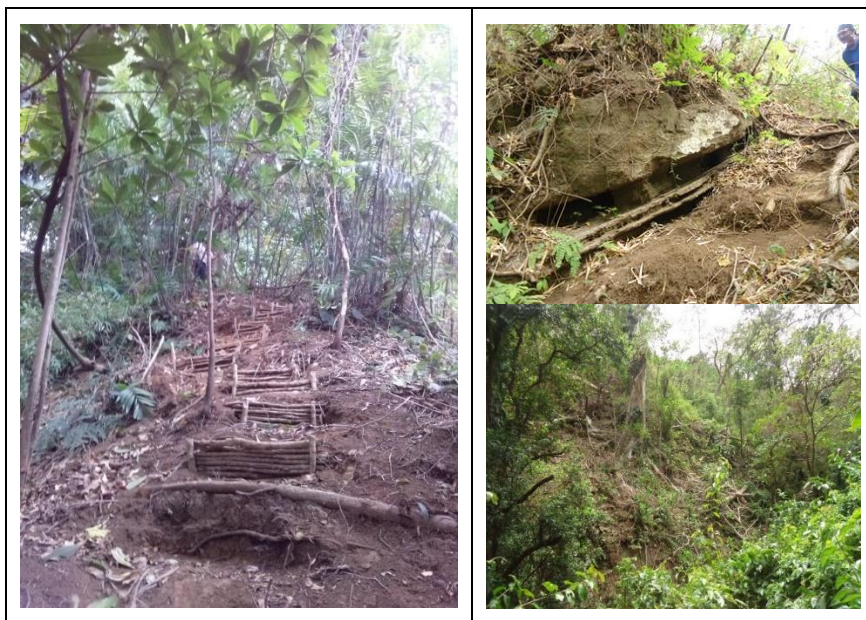
Figura 15: Áreas inestables en la finca
