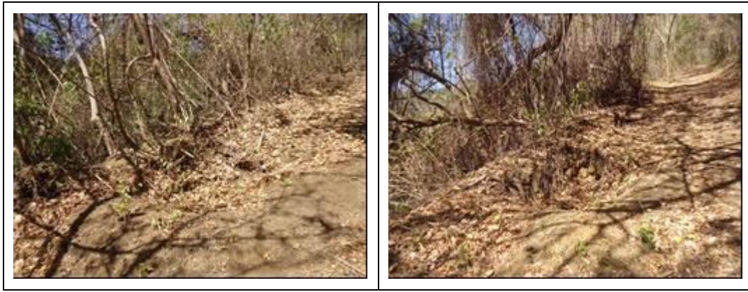
Figura 5: Cubetas de infiltración
