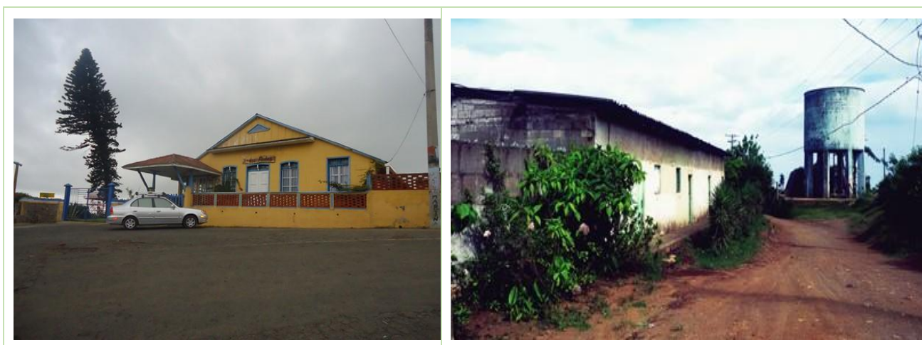
Figura 15: Principales instalaciones de la finca
