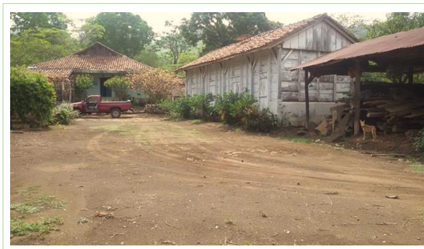
Figura 13: Principales instalaciones de la finca
