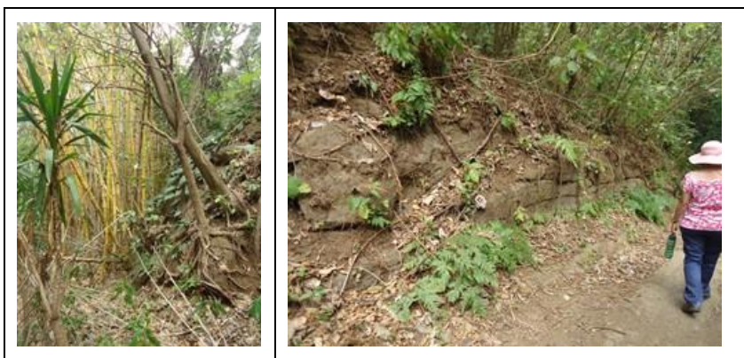
Figura 13: Áreas inestables en la finca
