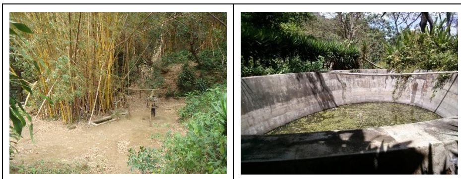
Figura 12: Pozo de agua potable y pila de almacenamiento
